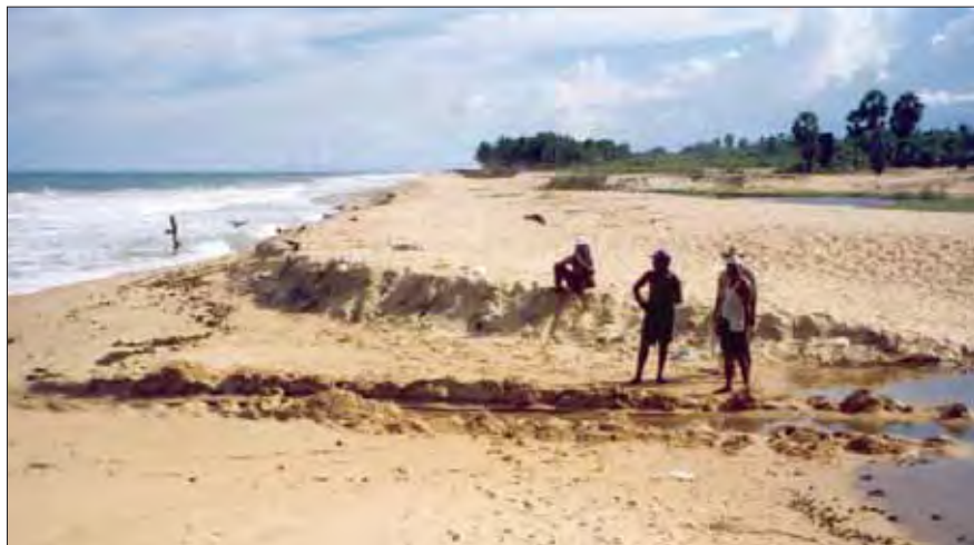
شکل ۳۰- ایجاد خلل و فرج در پشته‌های شنی برای اتصال مجدد لاگون به دریا
